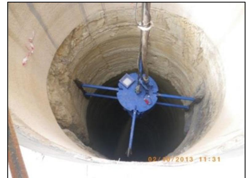
A unidade móvel de projeção está dotada de um motor hidráulico que produz a rotação da ponteira de projeção e dispõe de um sistema de CCTV e projetores de iluminação indispensáveis à monitorização do procedimento.
